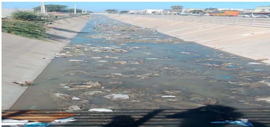
Ilustração 4. Imagem do desaguar da vala no mar
